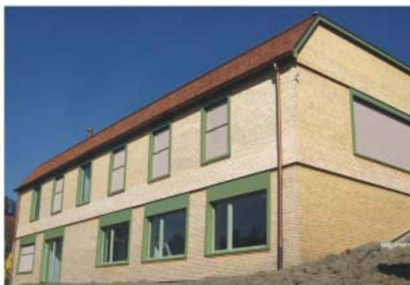
Neubau Kirchgemeindehaus Teufen, Appenzell Ausserrhoden, 2007 Lärchenschirm unbehandelt
